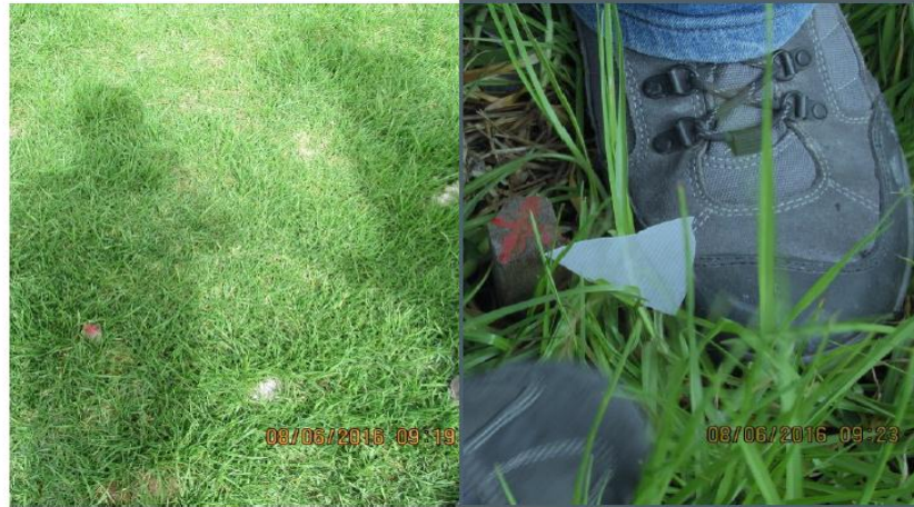
Fotografías 3 y 4. Estacas que indican la localización de las bases del puente a construir en las márgenes derecha e izquierda del canal Américas.
